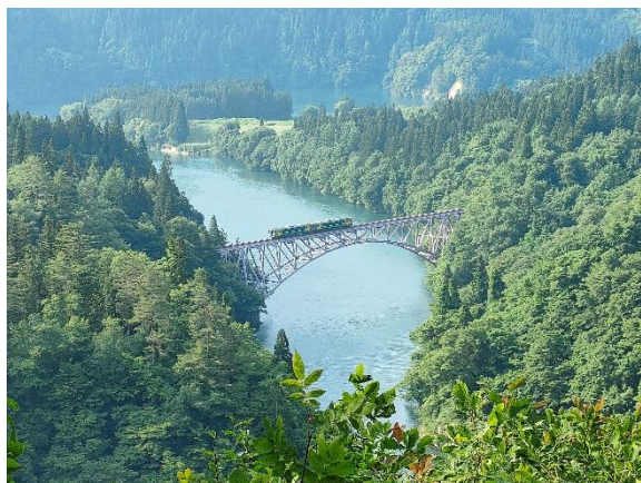
只見川第一橋梁
