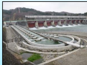
【宮中取水ダム】
