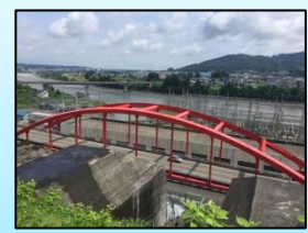
【小千谷発電所(車窓より)】
