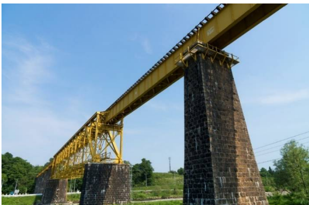
一ノ戸川橋梁(磐越西線)
