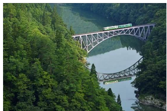
真夏の第一只見川橋梁
