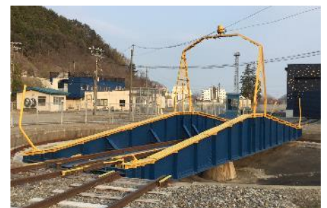
釜石駅転車台
