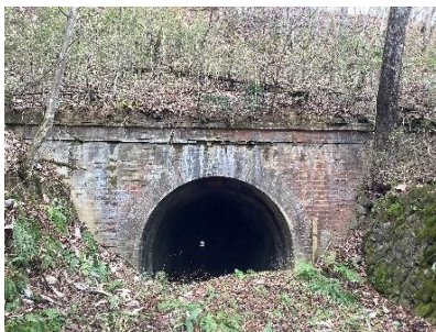
きゅうみやもりずいどう 旧宮守隧道
