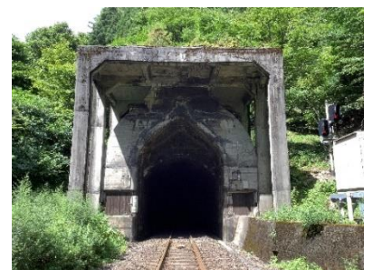
第二大橋トンネル排煙装置跡
