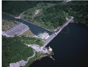
田子倉発電所
