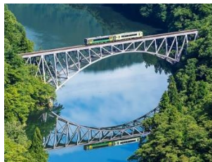
第一只見川橋梁
