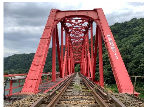
第 2 和賀川橋梁
