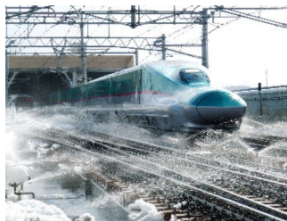
【散水消雪設備】
