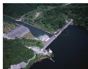
田子倉発電所
