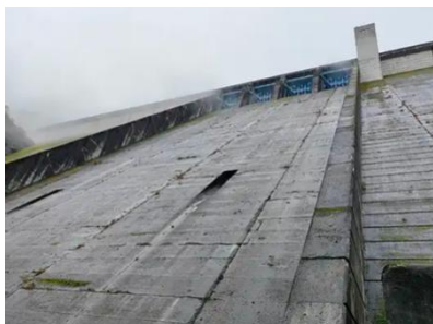
田子倉発電所
