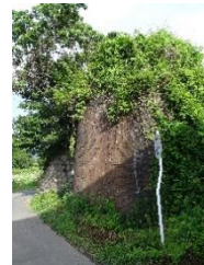
井出川橋梁橋台 (撮影：2024 年 12 月)
