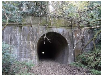
夕筋隧道 (撮影：2024 年 12 月)
