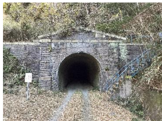
末続隧道 (撮影：2024 年 12 月)
